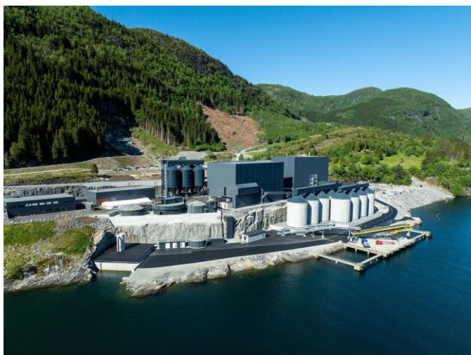
Figur 19 - Nordic Mining har etablert Engebø Rutile and Garnet AS som omfatter dagbrudd, prosessanlegg og utskipingsinfrastruktur (Foto: Jostein Vedvik)
