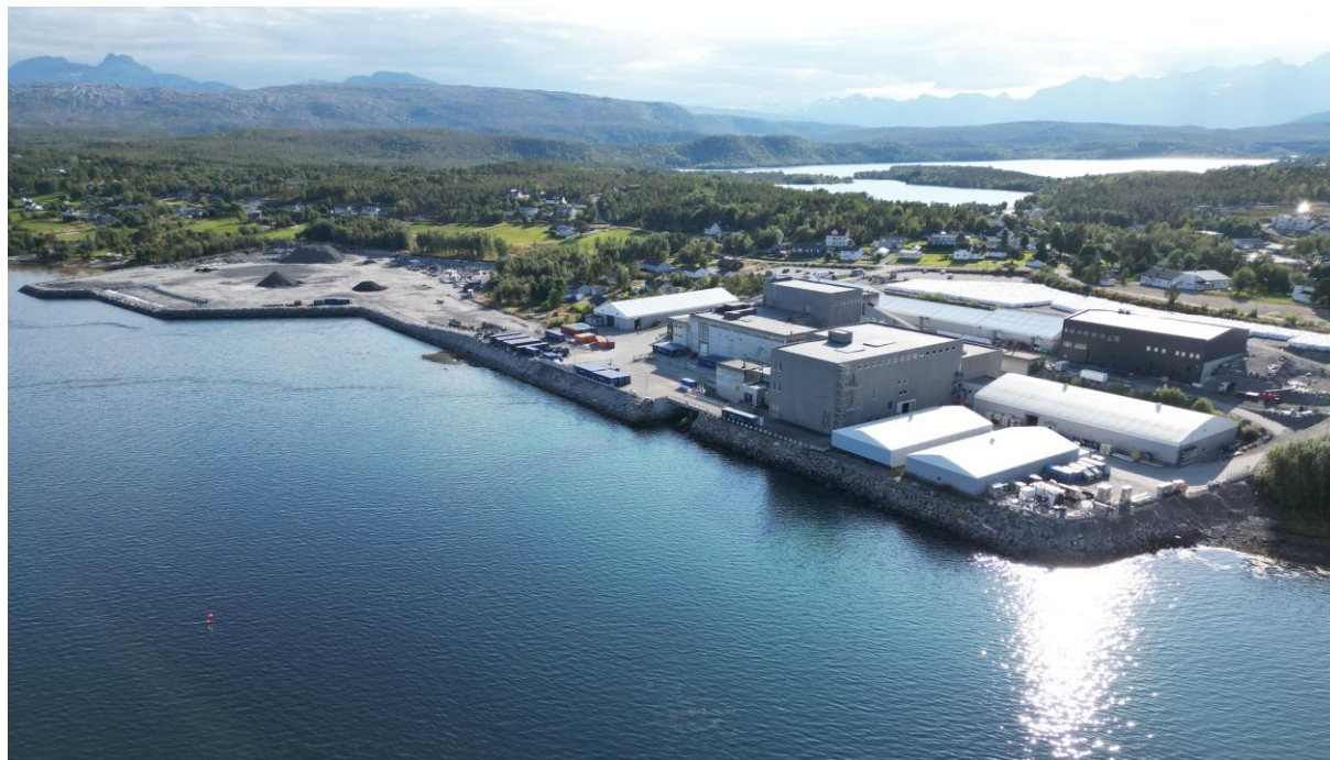
Figur 47 - The Quartz Corp ved Drag i Nordland (Foto: The Quartz Corp.)
